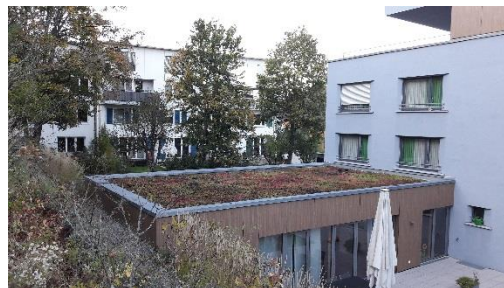
Dachbegrünung bei Neubauprojekten; Quelle: Riedl
