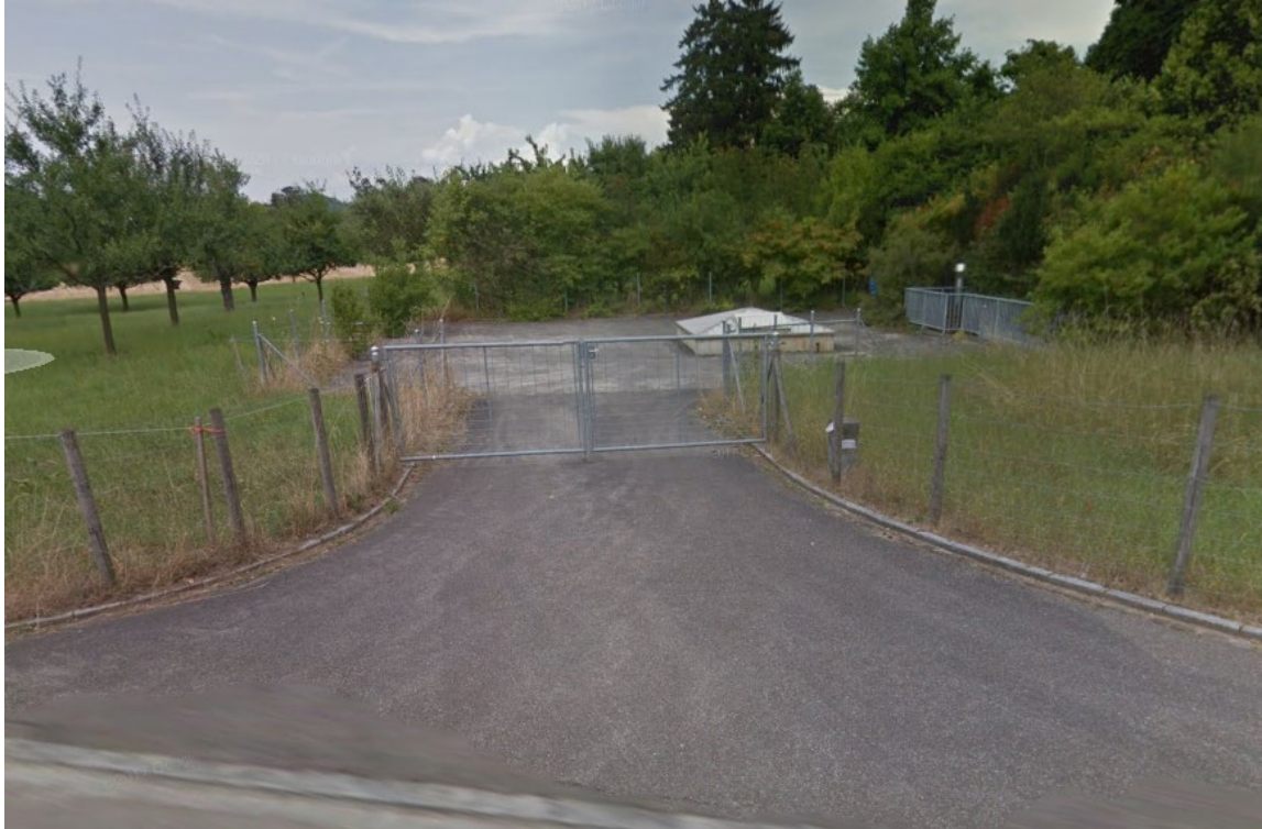
Bohrkeller der Bohrungen 1988/89
